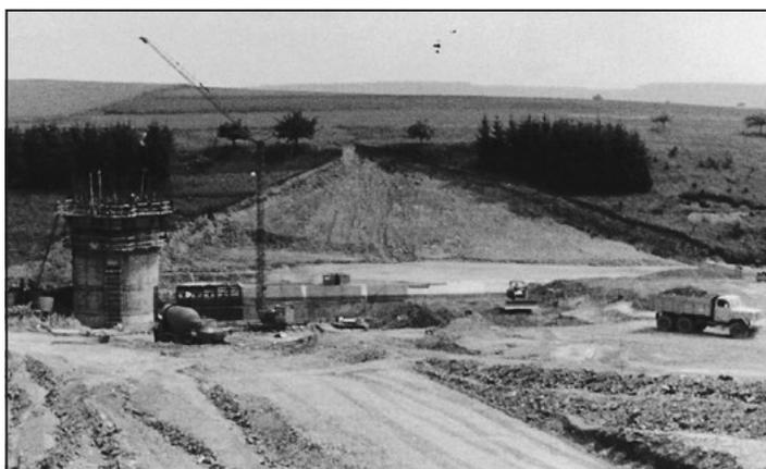
Blick auf den im Bau befindlichen Mönch und den Durchlass. Im Hintergrund ist das Widerlager des künftigen Steindammes erkennbar.
